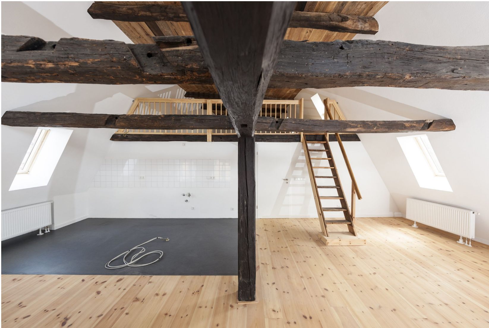
Güstrow, Gleviner Str. 1, ausgebautes Dachgeschoss im Vorderhaus © U Bunnemann
