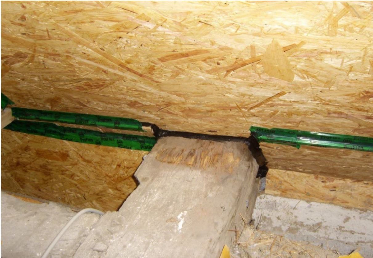
Dämmung im Deckenbalkenbereich © LAKD M-V/LD
