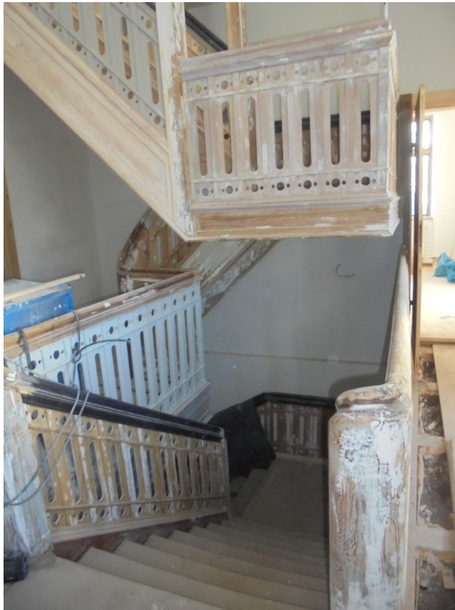
Treppe ins Dachgeschoss © LAKD M-V/LD
