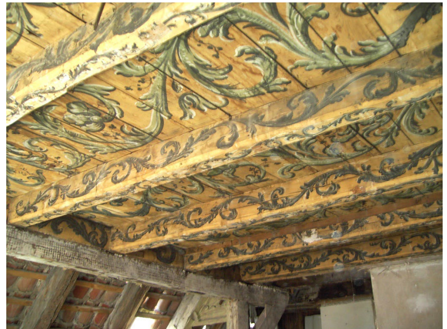
Deckenmalerei im Dachgeschoss © LAKD M-V/LD
