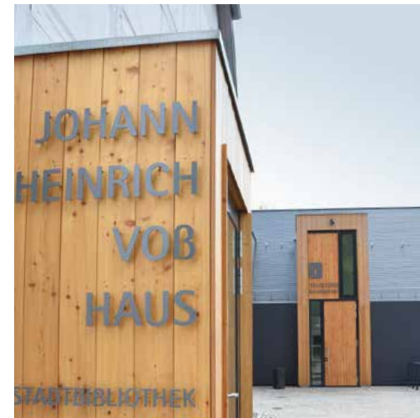
Eingangsbereich sowie Ausstellungsraum
